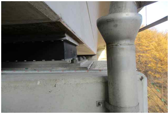
교량받침 연단거리 측정 현황
