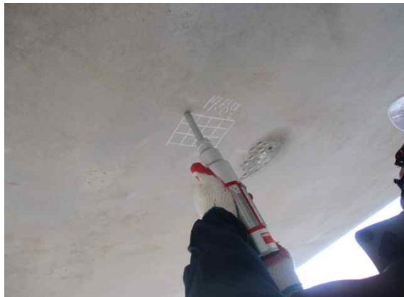
거더 압축강도 측정
