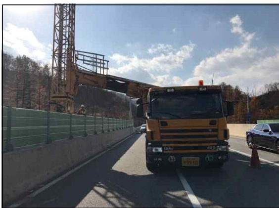
작업차량을 이용한 외관조사
