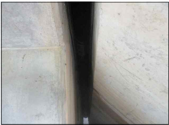
신축이음 하부 전경(A1)
