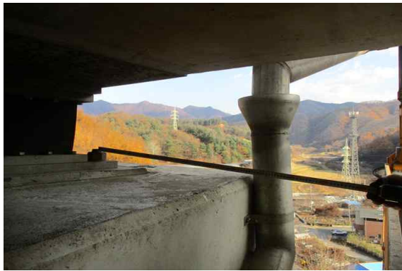
교량받침 연단거리 측정 현황
