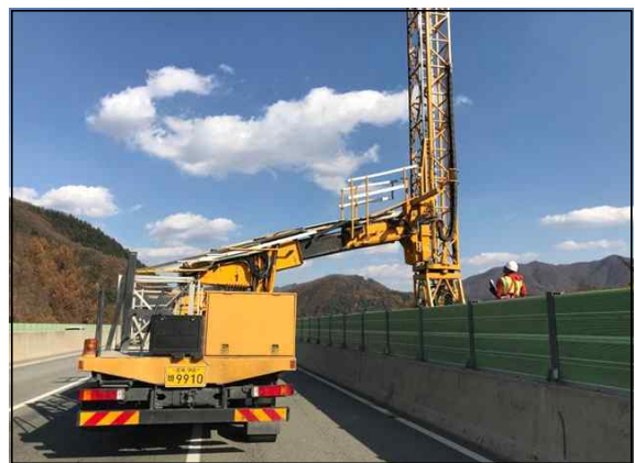
작업차량을 이용한 외관조사
