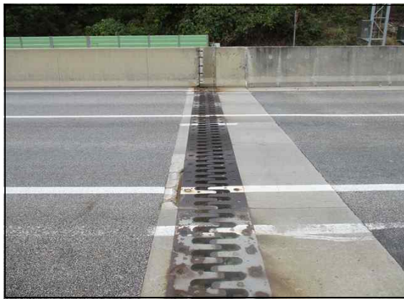
신축이음 상부 전경(A1)
